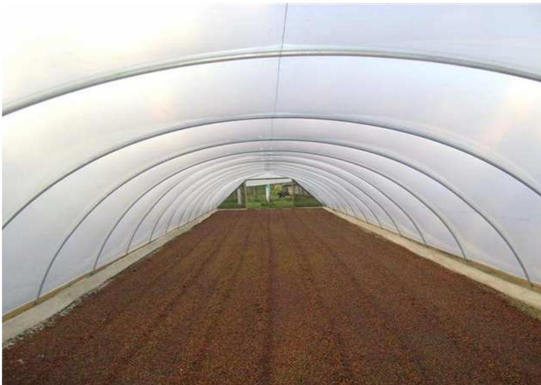
**FIGURA 3** – Estufa de secagem de café em terreiro de concreto
