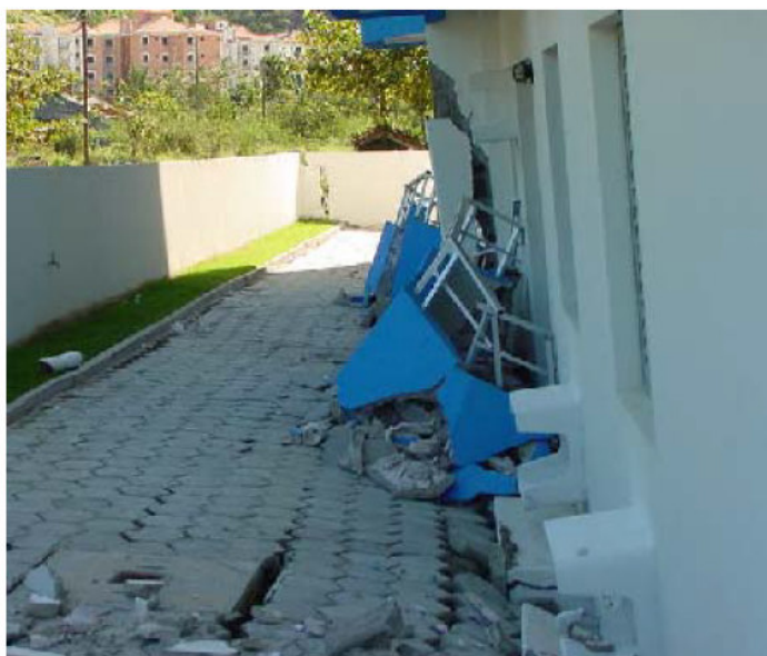
FIGURA 5 – Térreo deformado
