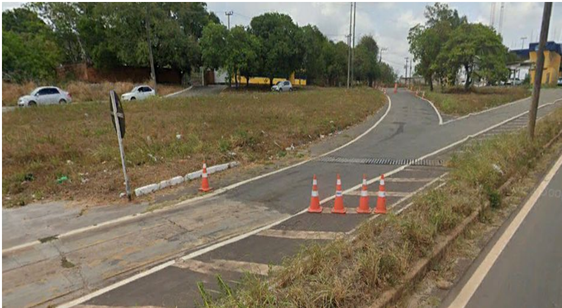
FIGURA 5: Entrada do PPV existente
