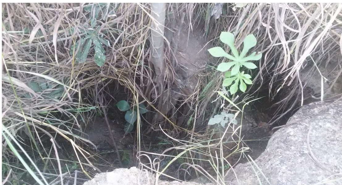
FIGURA 05: Início de processo erosivo
