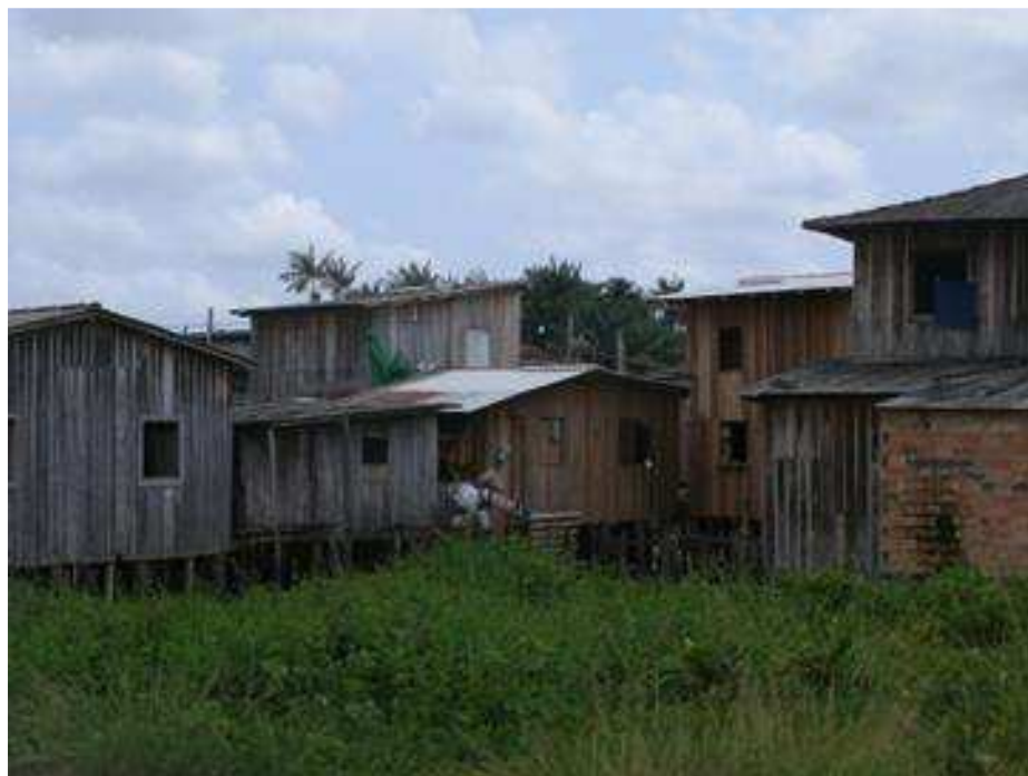
FIGURA 7 - Habitações palafíticas da área não saneada da Vila da Barca.
