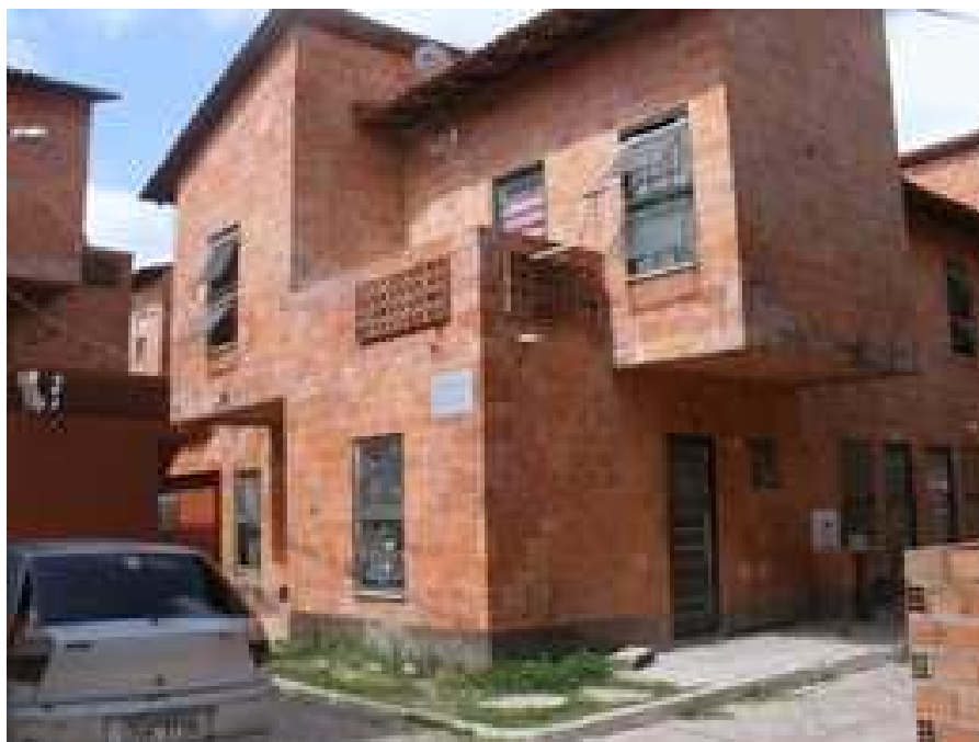
FIGURA 4 - Unidades habitacionais do Conjunto Vila da Barca.
