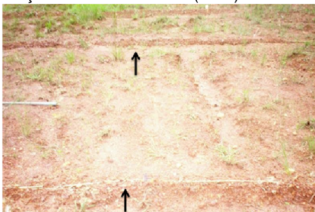
FIGURA 1. Paliçadas vivas instaladas na área, setas indicam os locais onde as paliçadas foram construídas.
