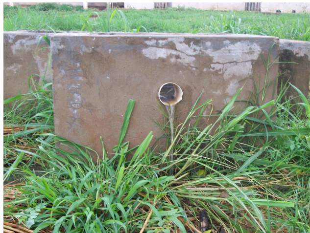
FIGURA 2 – Vazamento do canal de coleta. Fonte: Dados da pesquisa, 2010.
